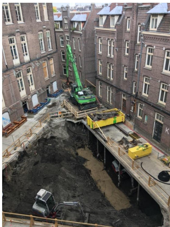
Figuur 1 – Graafwerkzaamheden binnenplaats
